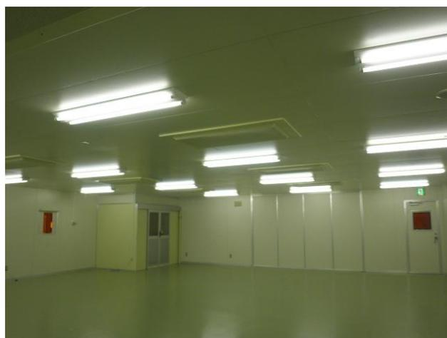
ルーム内はすべてLED照明、FFUの噴出し口は拡散パンチングで空気の流れを安定させます。
